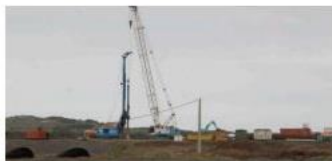
→ Les pieux servant de support au tablier du nouveau pont ont dû être implantés beaucoup plus profondément que prévu, ce qui a engendré une augmentation de la durée des travaux.
